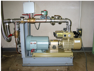
図22 . 設置したドライポンプ
