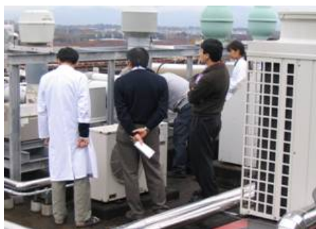
学系棟屋上で点検中の 安全管理担当教職員
