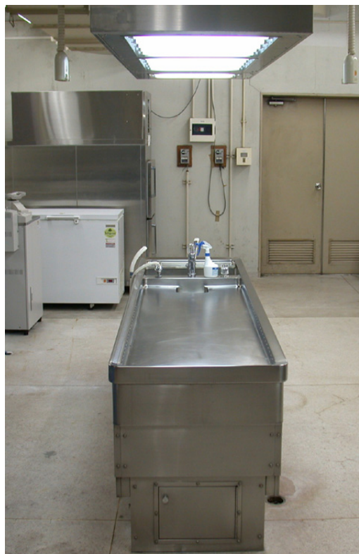
図5. バイオハザード対策用解剖台 解剖台上の蛍光灯外側より給気される。
