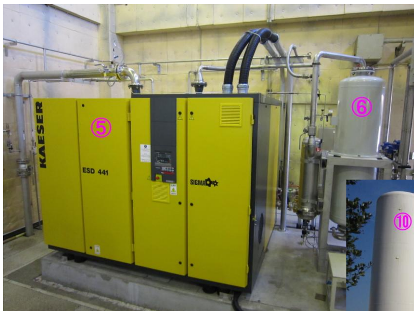
図3. 液化用ヘリウム圧縮機
