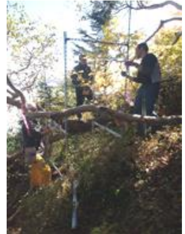
図 17.現地での組み立ての様子
