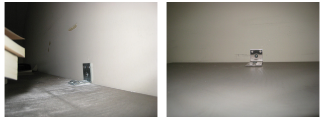
(E) ボード用アンカーを数か所設置した例
