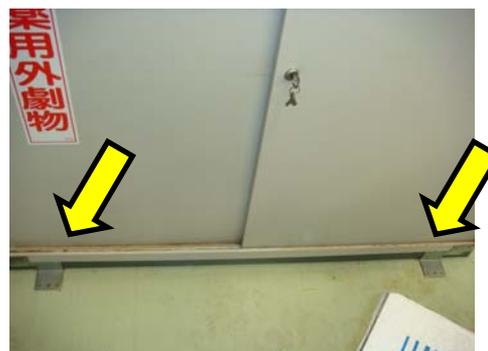
金具で床に固定された保管庫（臨床系実験室）
