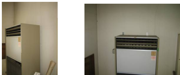
図 21. 壁から外れた空調機
