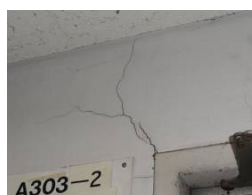
図 1. 壁の亀裂
