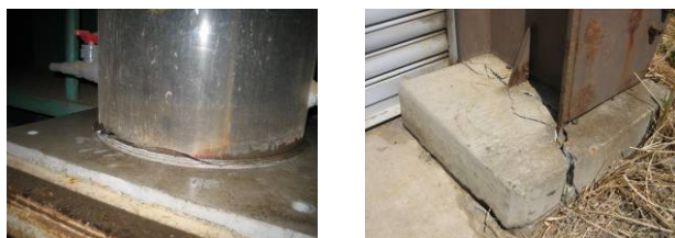
図 23. 割れた沈降管
