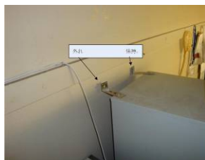
図 5. B 棟 4 階居室の転倒を免れた書庫
