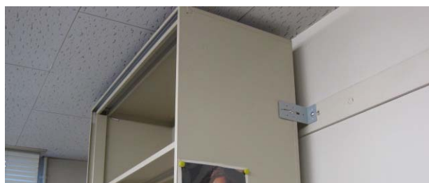
図22. 天井突張り書庫の棧への追加固定
