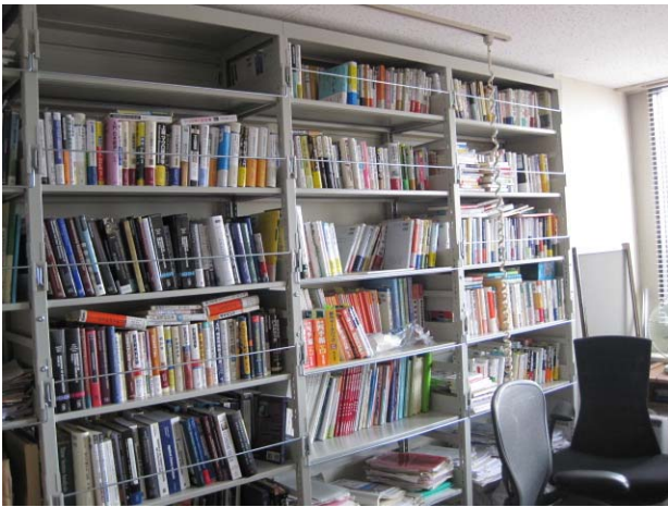
図 28. 落下防止装置付き書庫の使用例 (中央列上から3-5段目はアンロック状態)
