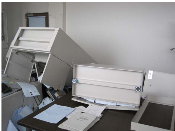
図 8. 天井突っ張りタイプの書庫の転倒
