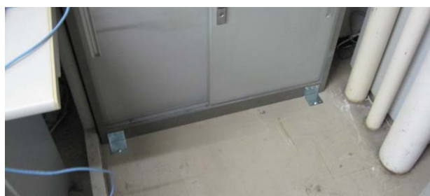
図23. 書庫の床面滑り止め固定
