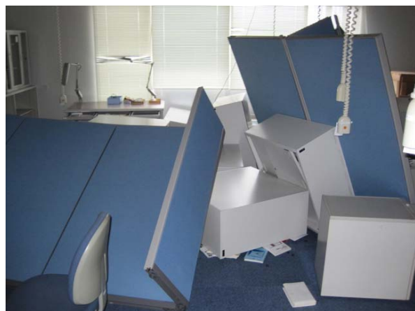
図 12. 室内パーティションの転倒
