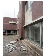
図 2. 外壁タイルの脱落
