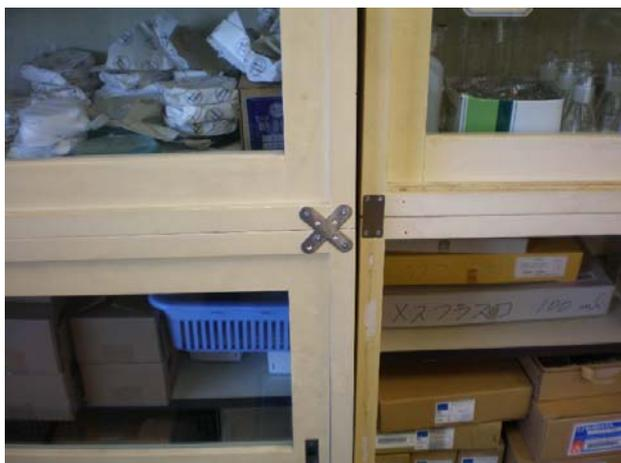
図 13. 震災前から上段と下段の戸棚を金具で固定
