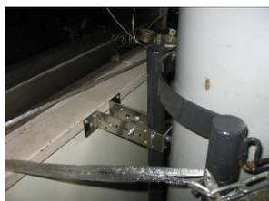
図 15. 高圧ガスポンペ立ての固定例
