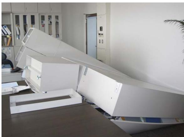
図 9. 重量バランスの悪さによる転倒
