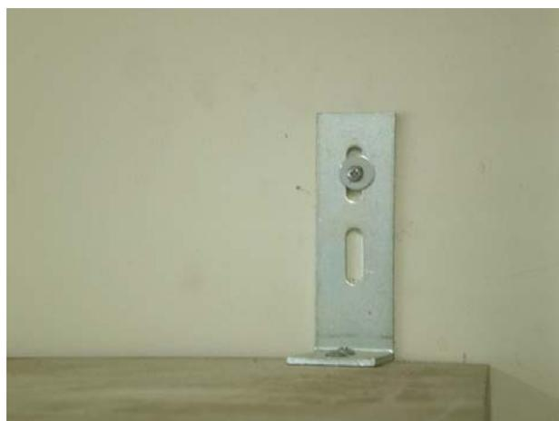
図12. 震災前から戸棚の上部をL字金具で壁に固定(震災後に撮影)
