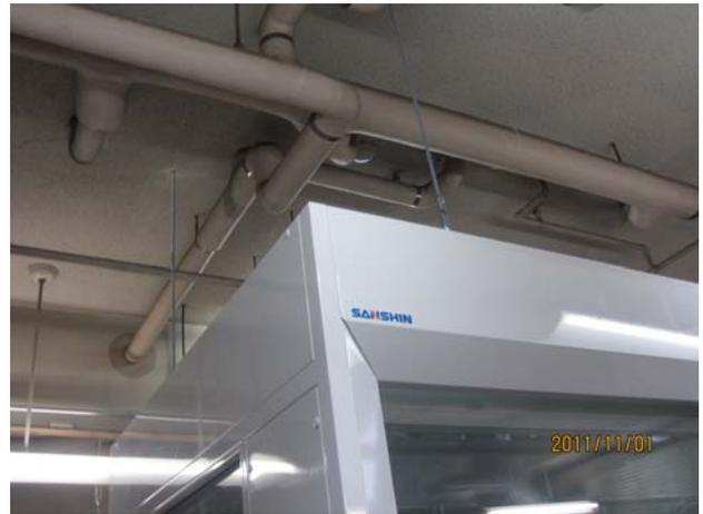
図3b. 局所排気装置を天井から吊り下げた様子
