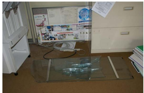
図 18. 落下して破損したガラス戸
