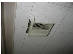
図 10. 6 階廊下天井ダクト周辺の破損
