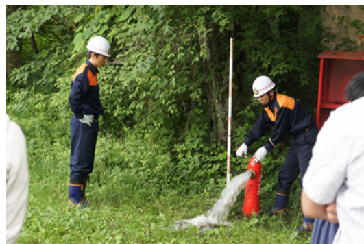
図 1. 消火栓と器具箱(右の赤い箱)
