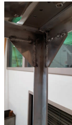
写真 2. 補強板溶接外観図
