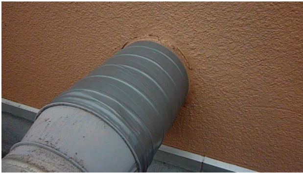
図 8. 補修後のダクト
