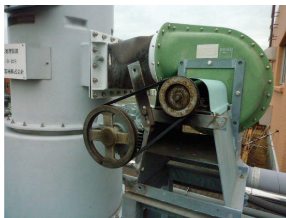
図6. ファンベルトの交換
