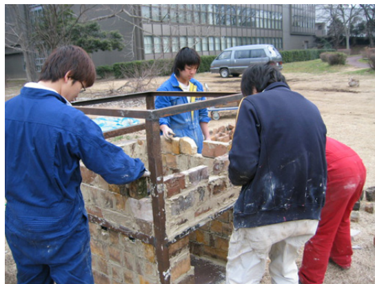
図3. 耐火モルタルで煉瓦を積む
