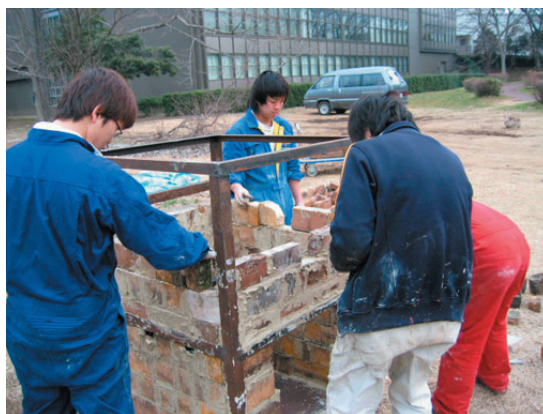
図3. 耐火モルタルで煉瓦を積む
