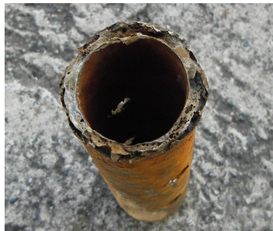
写真1. 劣化した金具
