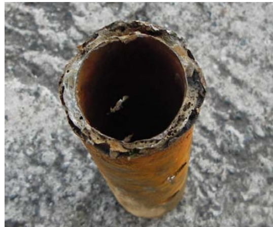
写真1. 劣化した金具
