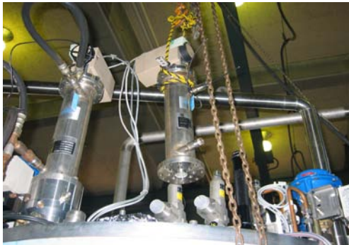
図5. Brake cooler 吊り上げ
