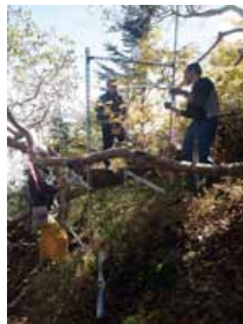
図 17.現地での組み立ての様子 梁を追加して固定する（図 17）。
