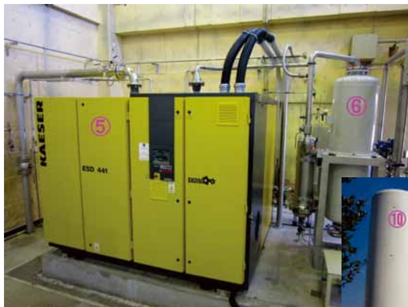
図3. 液化用ヘリウム圧縮機
