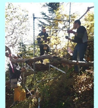
図17 現場での設置の様子
