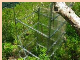
図8 ボルトが脱落したOTC
