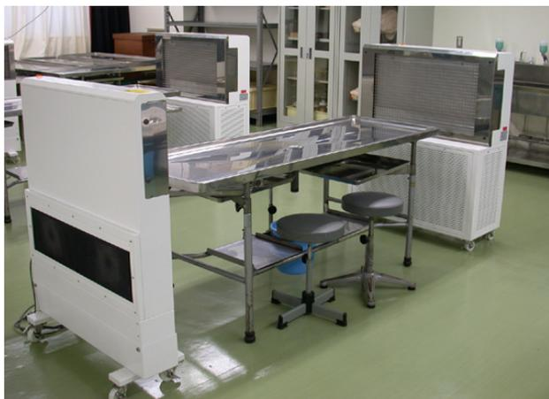
図 2. 還流方式プッシュプル型換気装置
