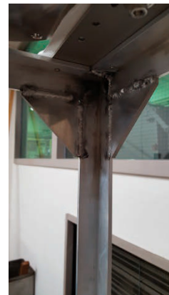
写真 2. 補強板溶接外観図
